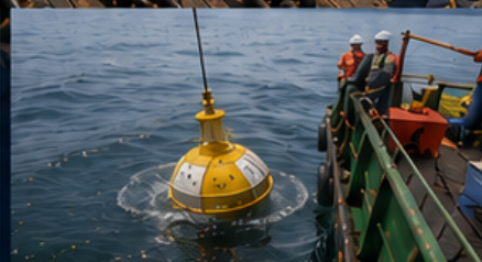
INSTALACIÓN DE BOYAS
